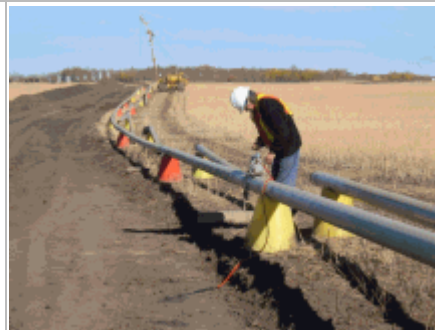
Image 6 : Inspection d'un pipeline END à l'aide d'équipement de gammagraphie industrielle
