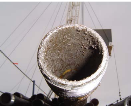
Pipeline contaminé aux matières radioactives naturelles (Photo : courtoisie de Tervita Corporation)
