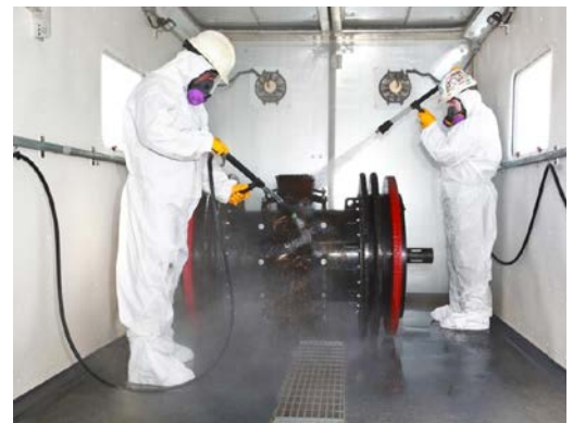
Nettoyage d'un pipeline (Photo : courtoisie de Tervita Corporation)
