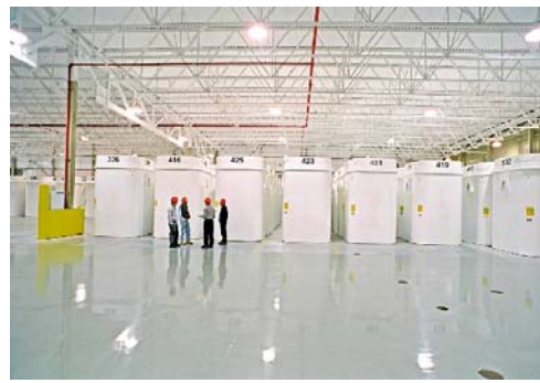
Figure 1.c. Conteneurs de stockage à sec pour le combustible usé (déchets hautement radioactifs) Source: Ontario Power Generation
